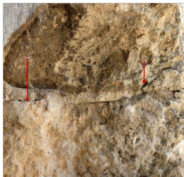
התפוררות של חומר המליטה מאפשרת חלחול מים לתוך הקיר
