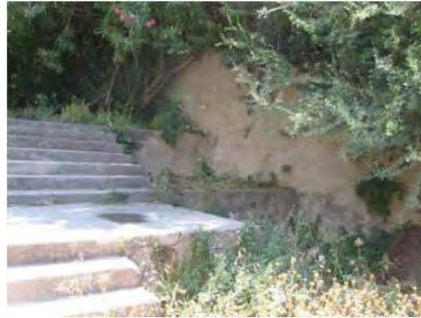
סדקים קלים וטיח מתקלף. קיר הטרסה בקצה הצפוני נטוי כלפי חוץ
