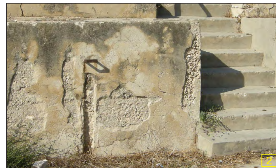
מבט לעבר אלמנטי החיבור של הפרגולה לטרסה
