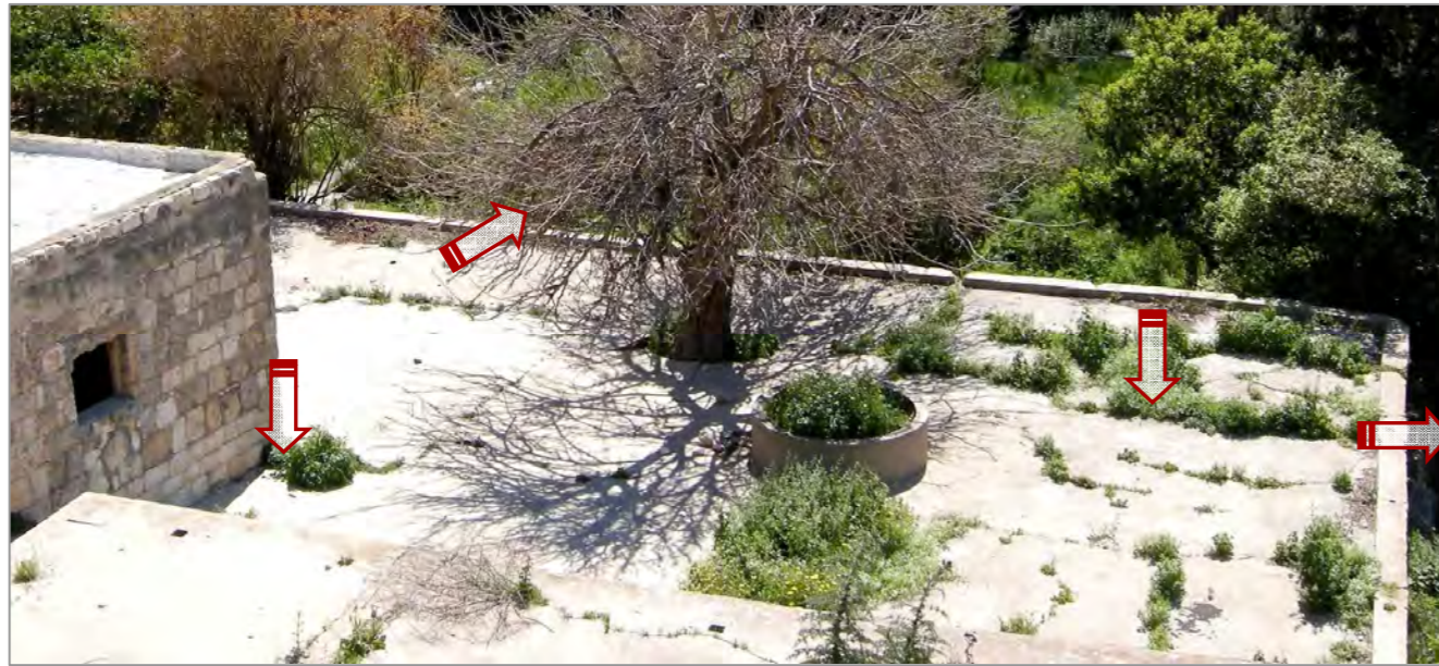
16א. דוגמא של מצב בשח: הפינה הדרום מערבית של הטרסה עליה נשען בית הגגן. העיוותים בטרסה מורכבים מהבעיות המפורטות לעיל: ▪ נטיית קירות התמך בחזית המערבית (בעיות 1-3); ▪ התנפחות של קיר התמך בחזית הדרומית (בעיה 5), תוך שקיעה והתהדקות אבני הדבש (בעיה 6), כתוצאה מכך, סדיקה בקליפת הבטון (בעיה 7), ▪ שקיעת המשטח העליון, סדיקה בריצוף הבטון (בעיה 8). ▪ המצב הוחמר על ידי שורשי העץ היוצרים דחף פנימי במילוי הטרסה (בעיה 13). ▪ קיימת גם בליית הבטון (בעיה 15)
