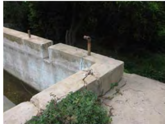
סדקים קלים וטיח מתקלף. קיר הטרסה בקצה הצפוני נטוי כלפי חוץ
