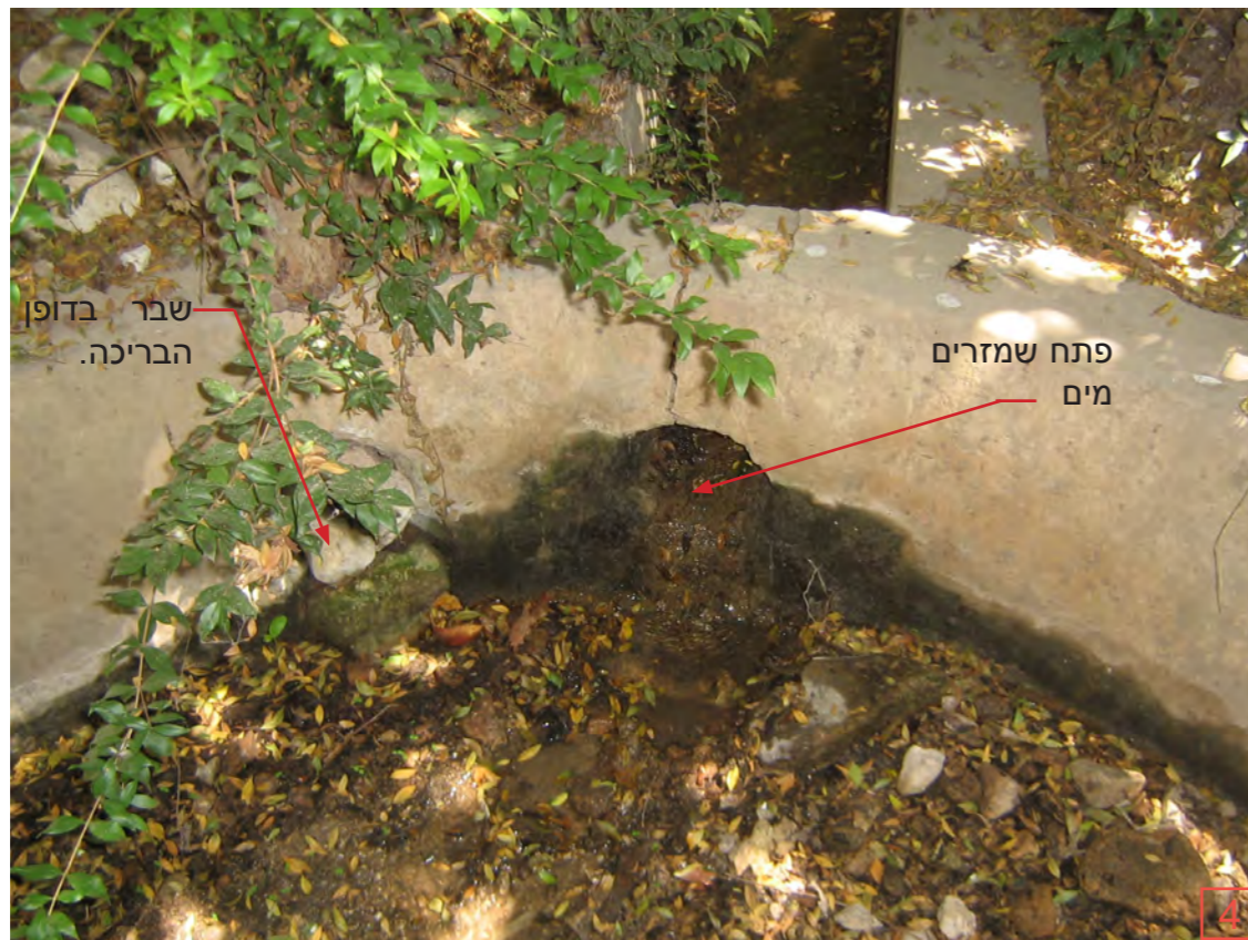
מבט לעבר החלל הפנימי של הבריכה המרכזית, פתח שנמצא בדופן של הבריכה שמאפשר זרימת מים מהתעלה הראשית לבריכה, שבר בדופן של הבריכה שמלאו באבנים.
