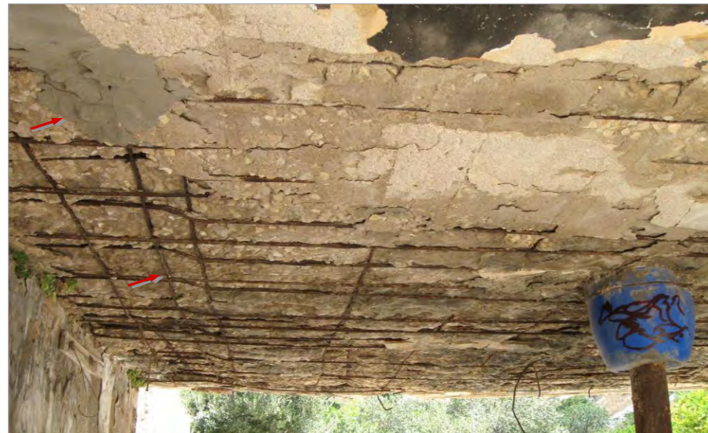
מבט ממזרח. מצב התקרה: מוטות זיון חלודים, בטון מתקלף, יש תיקונים מאוחרים.
