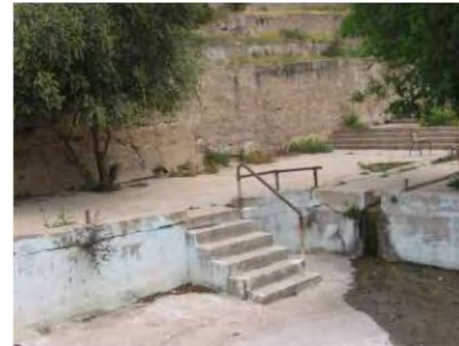
סדקים קלים וטיח מתקלף. קיר הטרסה בקצה הצפוני נטוי כלפי חוץ
